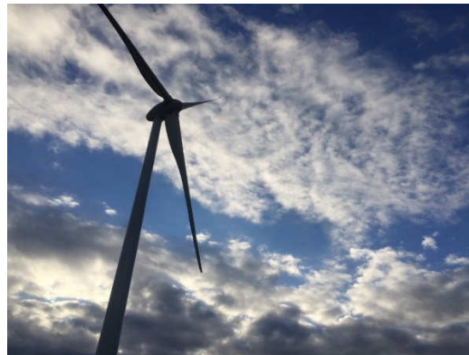
「万葉の里風力発電所」外観
